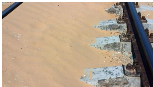
1-rasm. Uchquduq – Buzaubay peregonidagi temir yo'lning qum tez-tez bosib turadigan uchastkalari PK 273 + 50 ÷ PK 273 + 90
