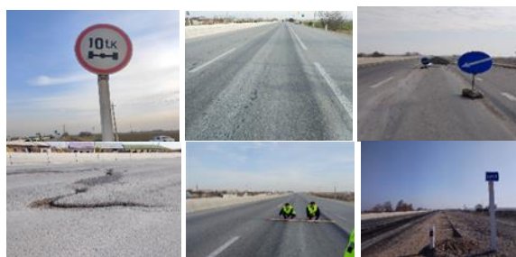
2– rasm. M-39 "Almata-Bishkek-Toshkent-Shahrisabz-Termiz" avtomobil yo'lining 1398-1420 km larda qoplama g'ildirak izi va siljish deformatsiyalar
