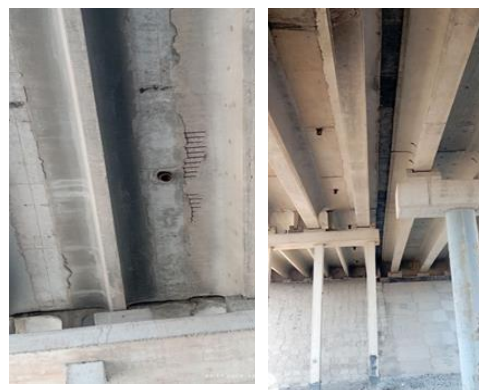
3-Rasm. Oraliq qurilmalardagi nuqsonlar
