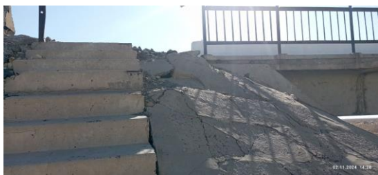
5-Rasm. Tutash uchastkalardagi qiyaliklar va konuslar ba'zi joylarda deformatsiyalangan
