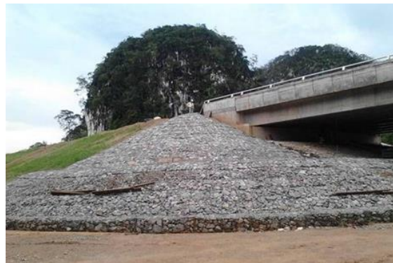
3-rasm. Ko'priklarni osti konuslaridagi gabion konstruksiyalar
