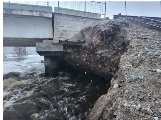
2-rasm. Ko'prik konusining yuvilishi. Rossiya Federatsiyasi Mondi-Orlik avtomobil yo'lidagi Sorok daryosi ustidan o'tgan ko'prik
