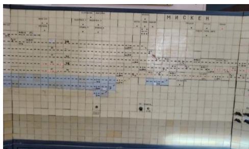
7-rasm. TVBU turidagi svetodiodli subbloklardan tuzilgan takomillashtirilgan (unifitsirovannyye) blokli tashqi tablolar
