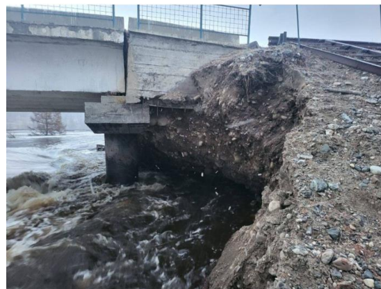
2-rasm. Ko'priklar konusining yuvilishi. Rossiya Federatsiyasi Mondri-Orlik avtomobil yo'lidagi Sorok daryosi ustidan o'tgan ko'priklar
