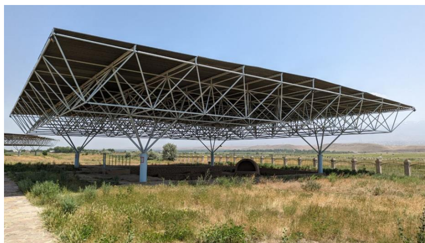
Рис. 3. Структурный блок «Кисловодск» 30 \times 30 м
