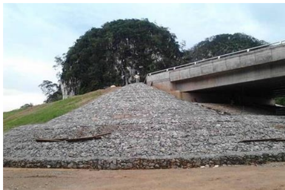
3-rasm. Ko'prik konuslaridagi gabion konstruksiyalar
