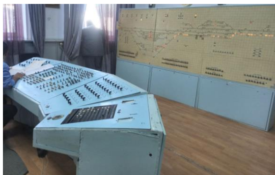
4-rasm. PPNB-1200 turidagi blokli elementlardan tuzilgan qiya egilgan (naklonnye) pult
