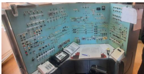
1-rasm. Elektr markazlashtirish tizimining PM-ES turidagi pult-manipulyatori va TV-ES turidagi maydon tablosi
