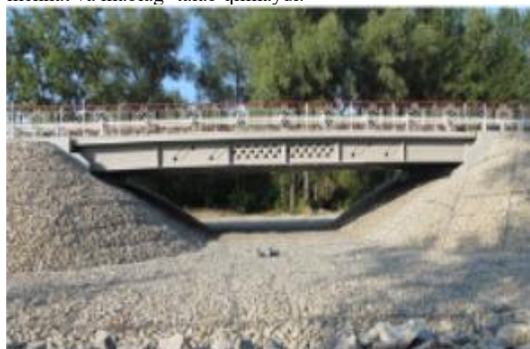
4-rasm. Ko'prik osti konuslarini gabion konstruksiyalar bilan mustahkamlash
