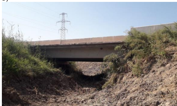
3-rasm. Ko'prik osti suv tas'irida yuvilishi natijasida tayanchlarning havf ostida qolishi
