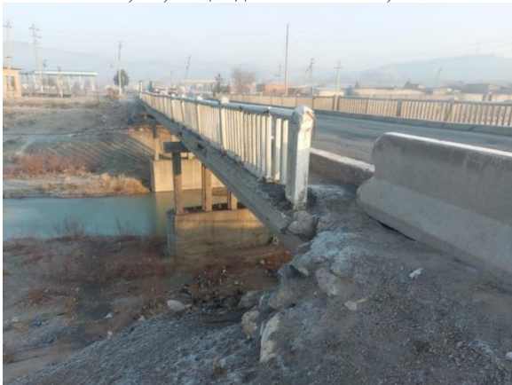
Рис. 1. Общий вид моста
