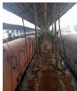
vagon-sisternalarni yuvish uchun mo'ljallangan estakada
